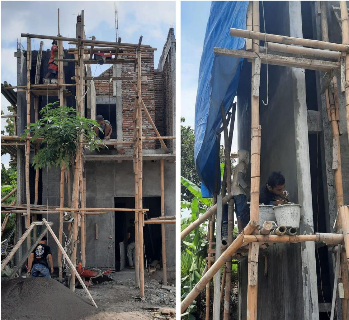
Gambar 1. Para pekerja di proyek pembangunan perumahan Kailila Urban Houses
