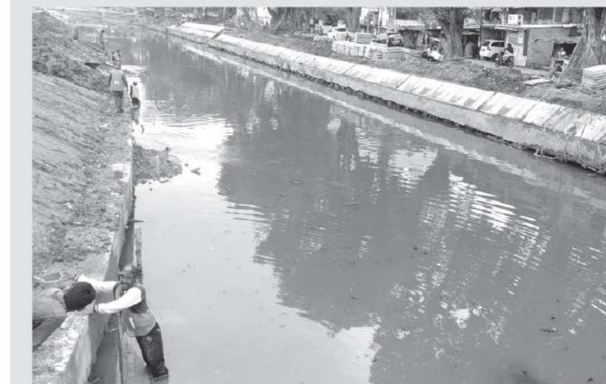
PLESTER TURAP – Sejumlah pekerja Sungai Sekanak-Lambidoran memplester dan memasang dinding atau turap beton di proyek Sungai Sekanak-Lambidoran di Kelurahan 26 Hl Palembang, Minggu (3/10/2021). Pembangunan tahap ke II tersebut sudah dilakukan beberapa bulan lalu dan diharapkan selesai di akhir Oktober 2021.
