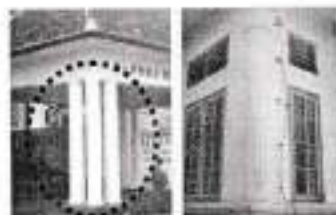
pintu masuk sudut bangunan
