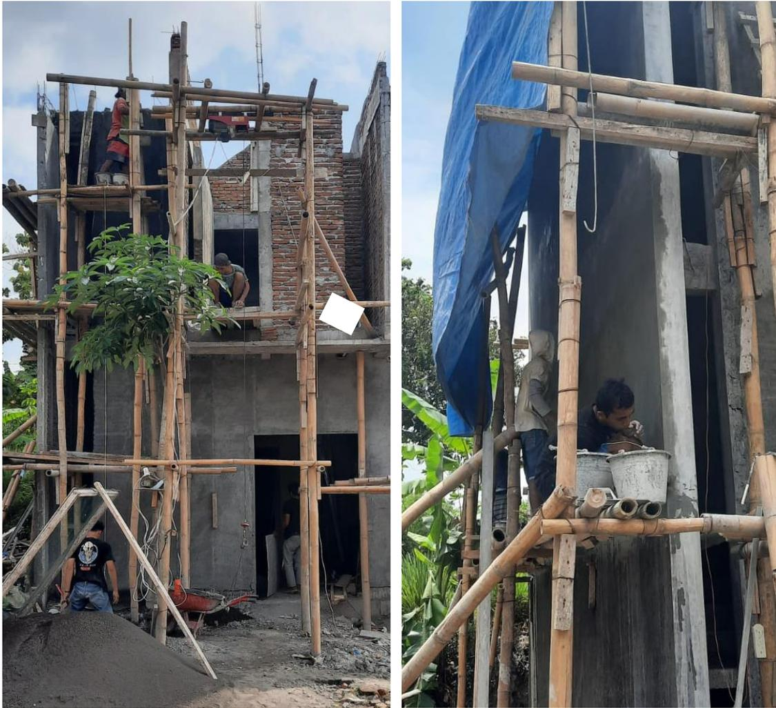
Foto 2. Para pekerja bangunan di proyek konstruksi pembangunan perumahan Kailila Urban Houses yang bekerja tanpa alat pengaman sama sekali
