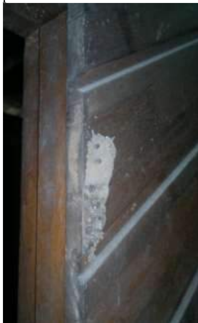
Gambar 14b. Sarang Kumbang pada dinding kayu
