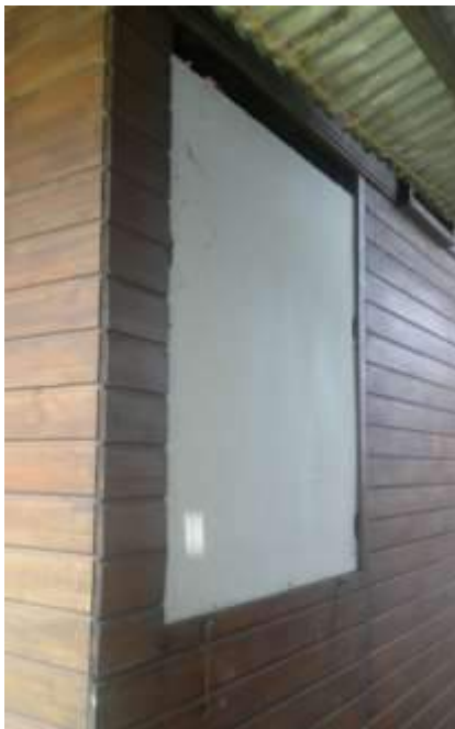
Gambar 10a. Jendela ditutup dengan kertas, menghambat proses sirkulasi udara
